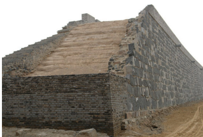
Рис. 1-12. «Разрез» стены, построенной в эпоху империи Мин (1368-1644 гг.)
