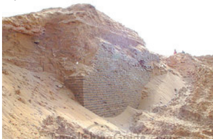
Рис. 1-10. Участки Китайской стены. Видно, что они сильно разрушены ветровой эрозией и засыпаются песком.
